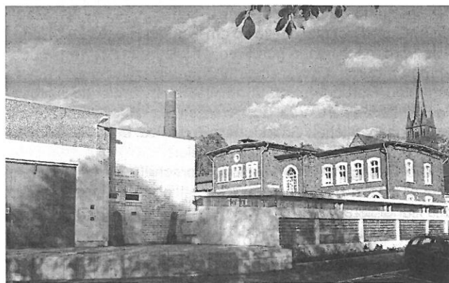
Mitten in der historischen Gebäudesubstanz des ehemaligen Klosters Haina (heute psychiatrisches und forensisches Krankenhaus) ist das Biomasseheizwerk Haina eingebunden. Im Vordergrund der 330 m 3 fassende Hackschnitzel-Bunker.
