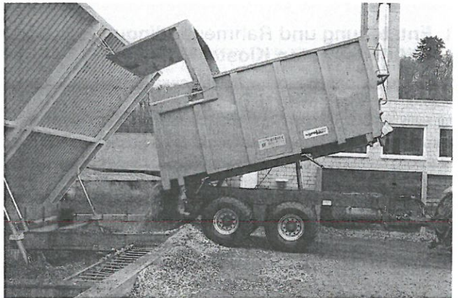
Die Hackschnitzel werden in den ebenerdig anfahrbaren Bunker abgekippt. Die Bunkerklappen sind hydraulisch zu öffnen.
