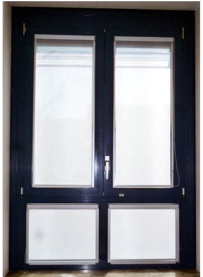
Innenansicht mit Stoffbehang
