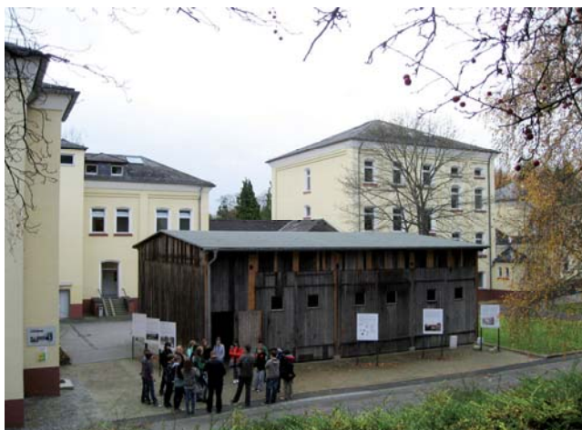
Die ehemalige Busgarage
