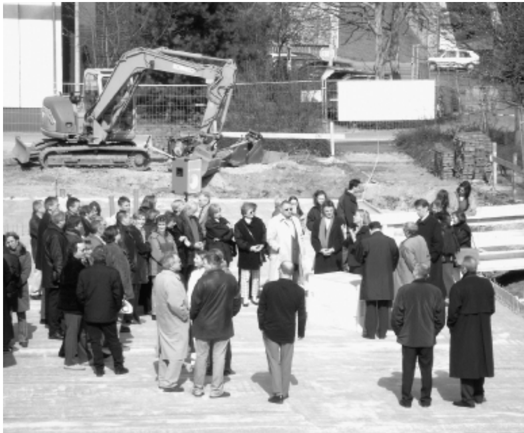
Große Gästeschar bei der Grundsteinlegung.
