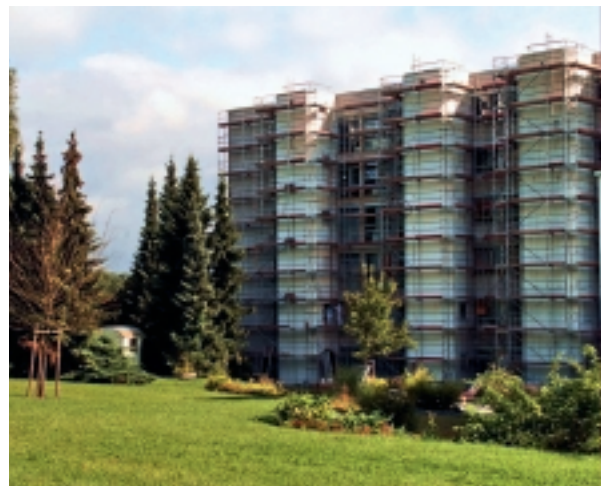
Eingerüstet: Die Fassade des Bettenhauses im Juli 2007.
