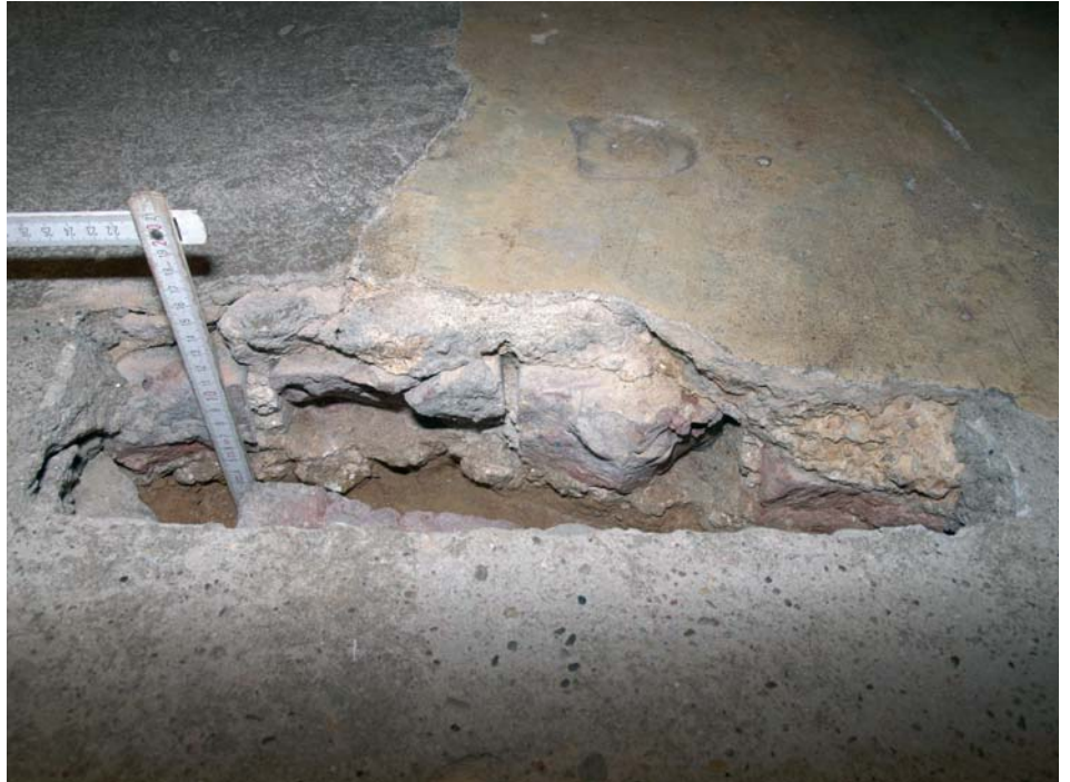
Sondage am Rand der „Schleifbahn“ im Rahmen der bauhistorischen Untersuchung, Foto: Axel Drieschner, 2014.
