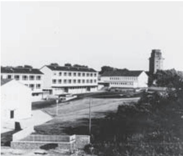
Die 1957 bezogenen Neubauten der heutigen „Johannes-Vatter-Schule“ mit Heim und Kindergarten in Friedberg
