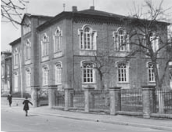
Historisches Schulgebäude der Freiherr-von-Schütz-Schule in Bad Camberg
