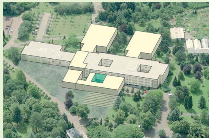
MEHRERE BAUABSCHNITTE: In Gießen entsteht ein neuer Gebäudekomplex.
